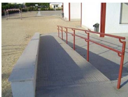
Rampas con señalización (Montilla)
