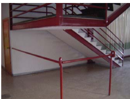
Escalera con protección (Montilla)
