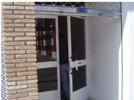
Puerta con señalización (Montilla)
