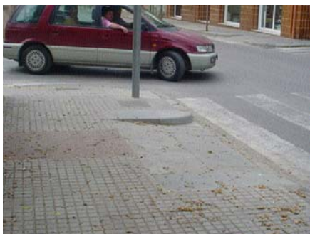
Ejemplo de vado peatonal señalizado con pavimento diferenciado
